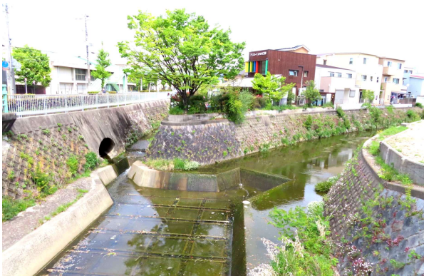
兎川合流部の落差工
