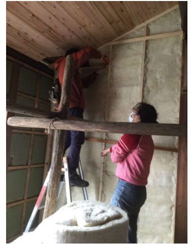
壁に羊毛を入れる作業
