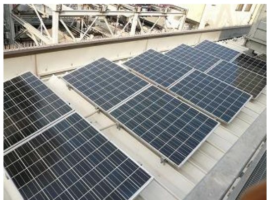
環境交流センターの屋上へ移設
